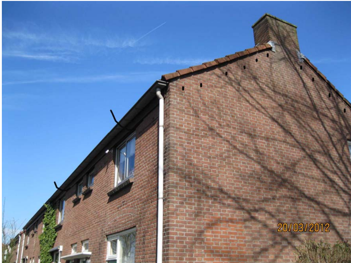
Overzicht van de panden, zoals die in het hele plangebied zijn. Open stootvoegen en kierende plaat aangegeven
