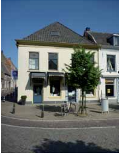
Afb. 70 Voorstraat 6 - hoek Langendijk
