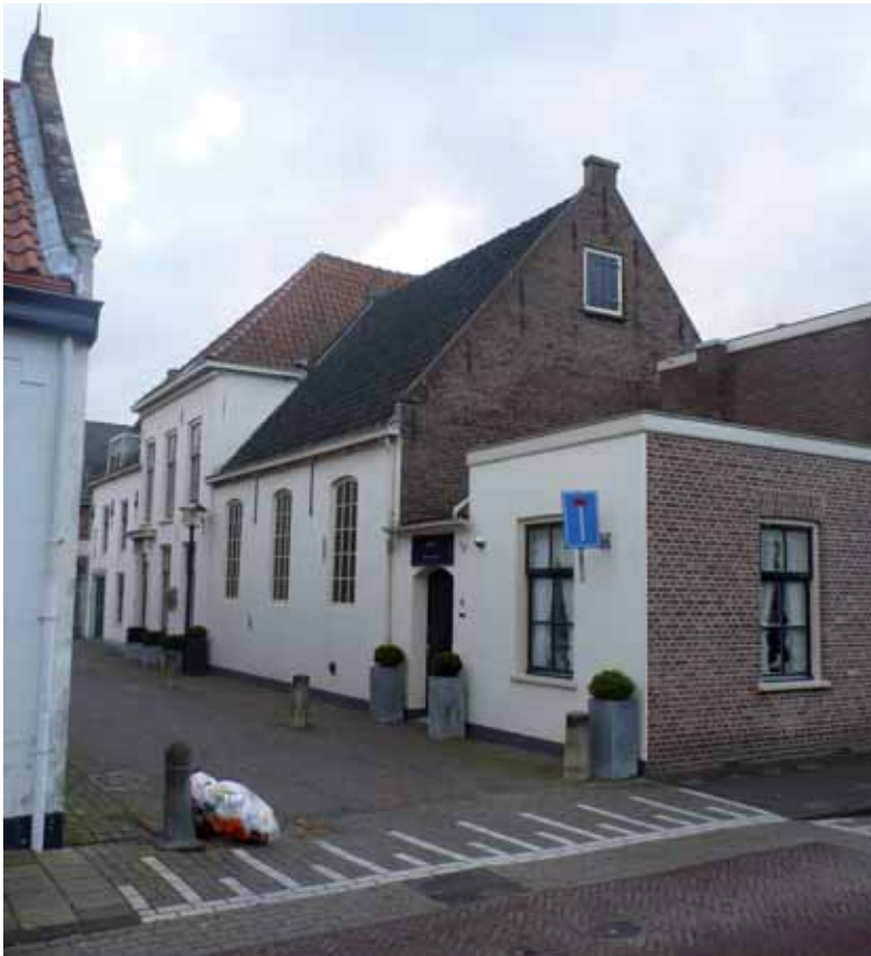
Afb. 79 De voormalige synagoge aan de Bakkerstraat
