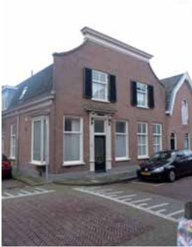
Afb. 9 Achterstraat 22 - hoek Stalstraat
