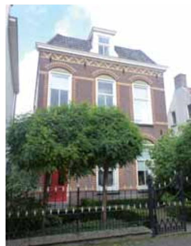
Afb. 40 Langendijk 28, het voormalig gebouw van het hoogheemraadschap De Vijfheerenlanden
