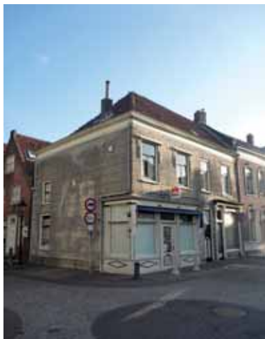
Afb. 36 Langendijk 2 en 4 / hoek Voorstraat
