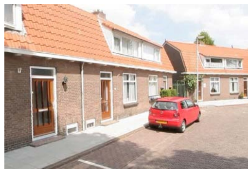
Rijenwoningen aan de ME Hartmanstraat
