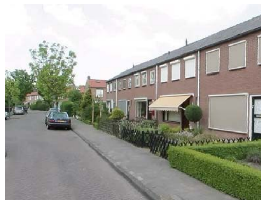
Rijwoningen Jan van Arkelstraat in het zuiden van de Hagen
