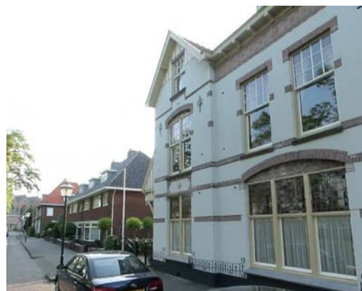
Grote diversiteit aan architectuurstijlen, zoals aan de Pr. Julianastraat
