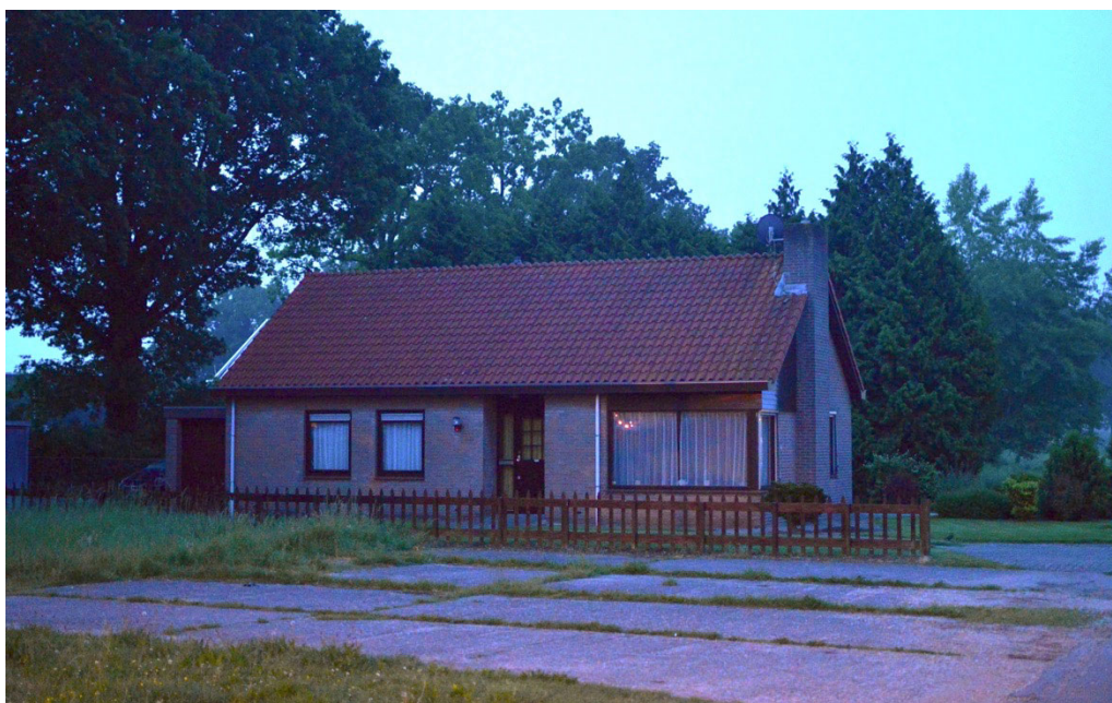
Figuur 2.4 De woning in het zuidelijk deel (situatie 28 mei 2016)
