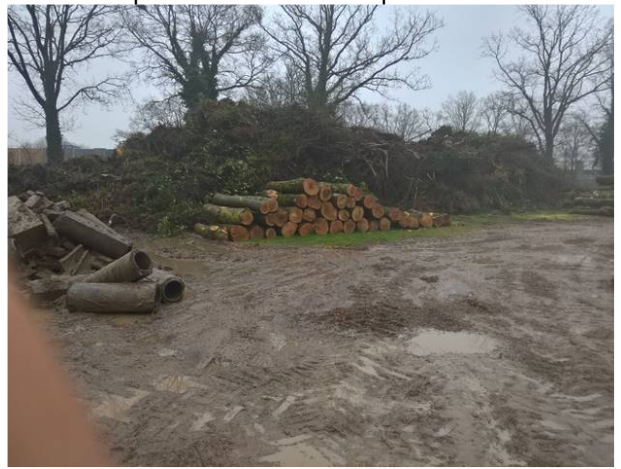
F6: Situatie bij boorwerk (opslag hout/groen)
