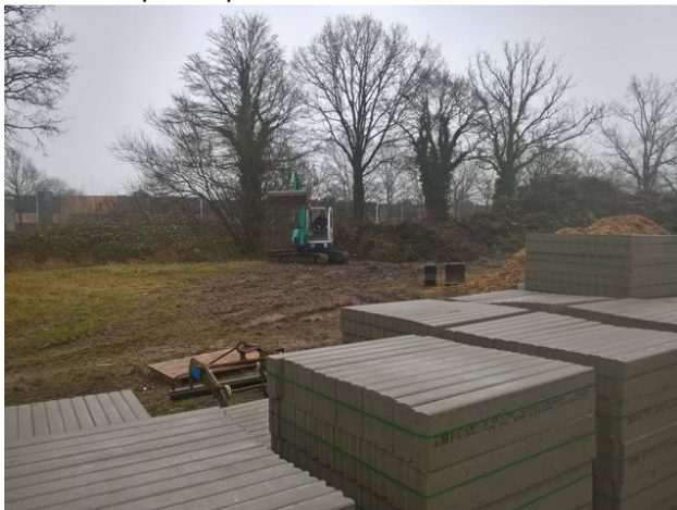
F5: Situatie bij boorwerk (opslag klinkers/groen)
