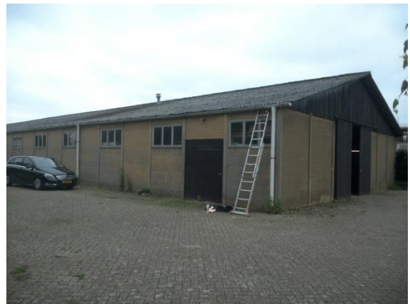
Foto 4. Asbesthoudende golfplaat inclusief hulpstukken (bron Bron1)
