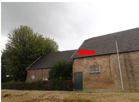
Foto 5: openingen bij dakrand
