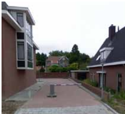
Ingang parkeerhof overzijde Emmastraat
