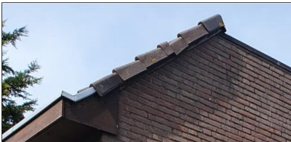
Figuur 7 Visuele ondersteuning van het nauw aansluiten van de kantpannen op de aluminium daklijst.
