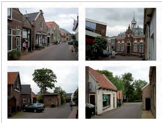
Poortugaal: historisch centrum
