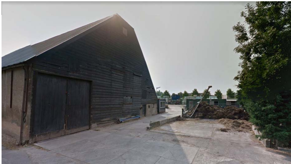
Afbeelding 2.2: Zicht op het achtererf (bron: Google Streetview)
