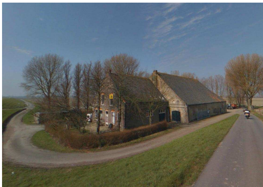
Foto: bestaande bebouwing Aaldijk 3 (bron: Globespotter)
