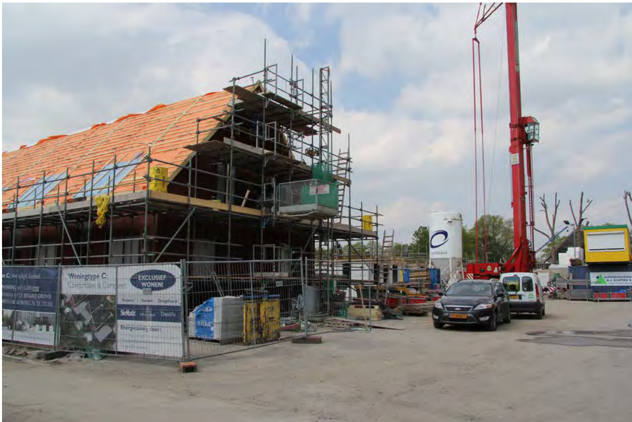
Senioren- en starterswoningen in aanbouw, Mijnsheerenhof
