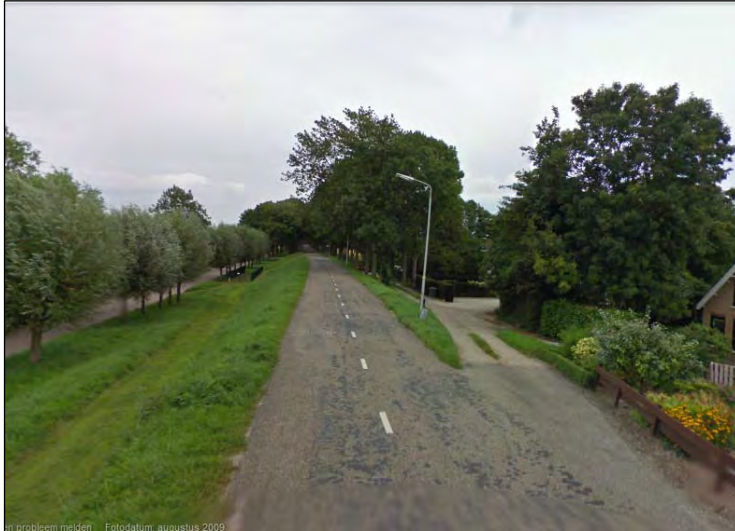
Figuur 3.8: Afrit Schuringsdijk richting woningen (Bron: Google maps)
