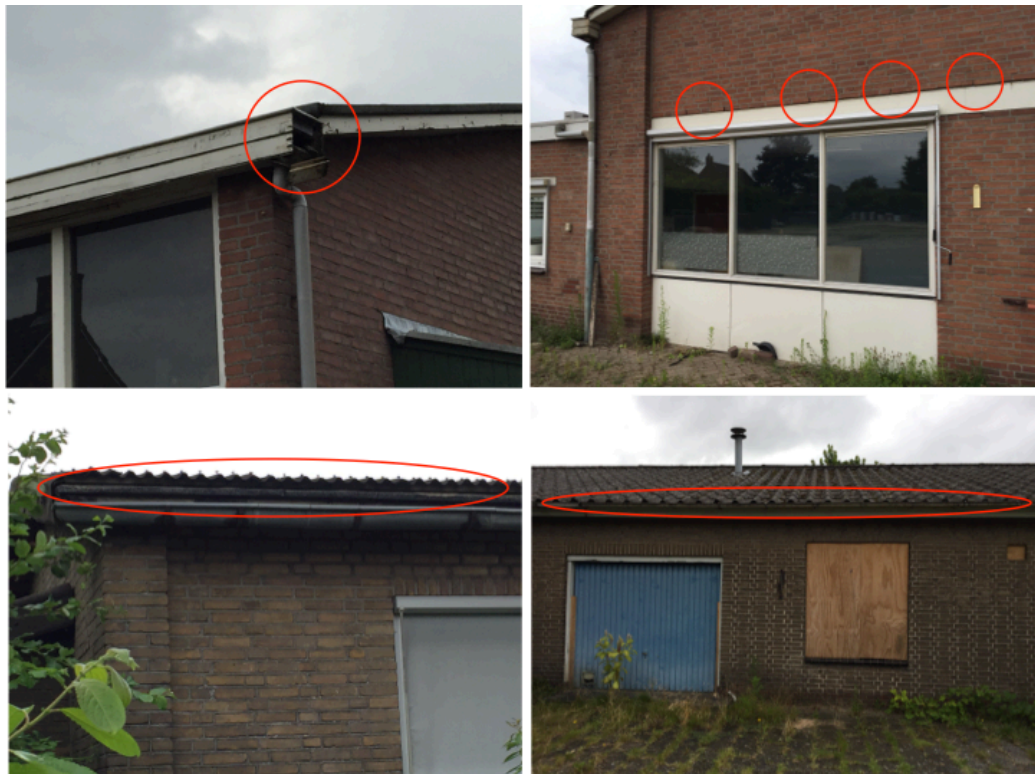
Figuur 3 De bebouwing op de planlocatie is potentieel geschikt als verblijfplaats voor vleermuizen. De rode cirkels indiceren enkele mogelijke invliegopeningen.
