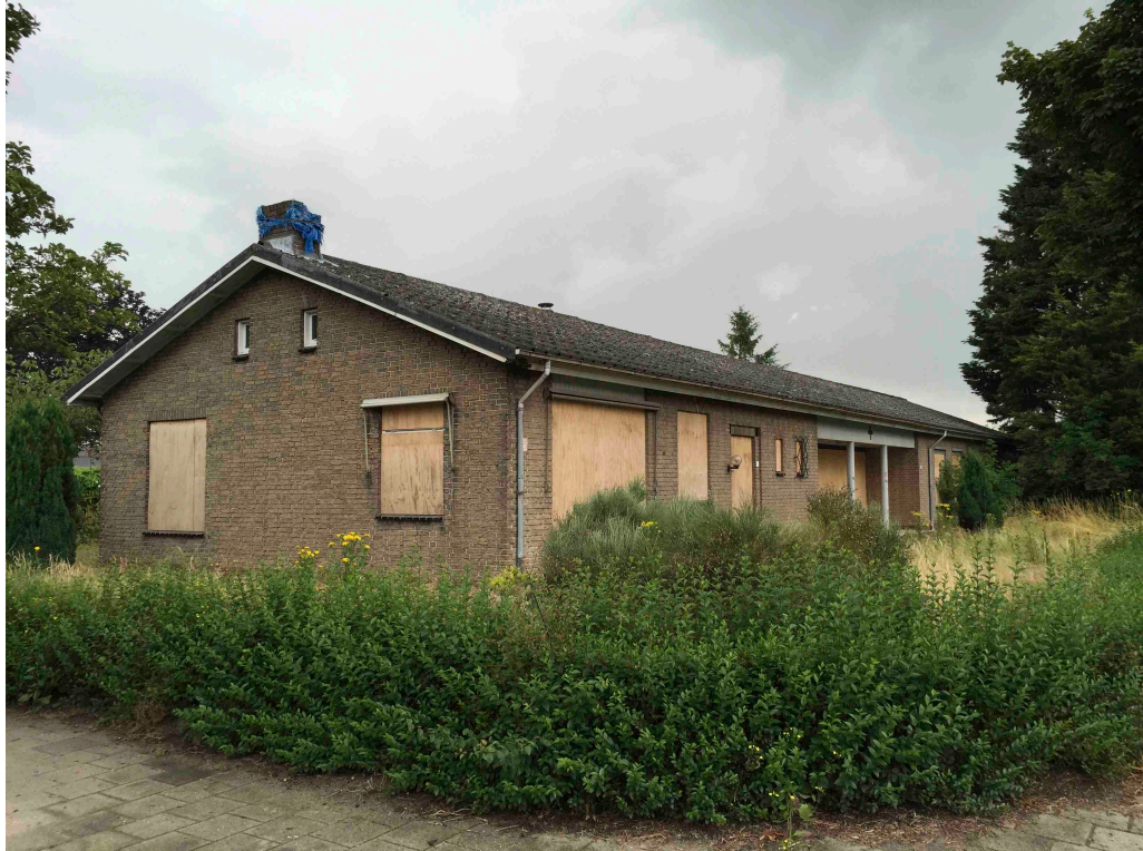
Figuur 3 Het gebouw van het Groene kruis is niet meer in gebruik de deuren en ramen zijn gebarricadeerd met houten platen.
