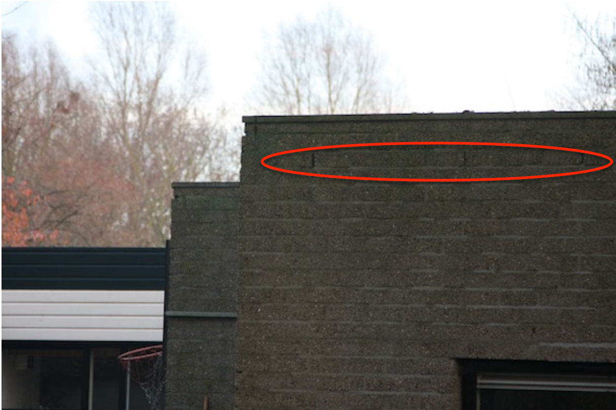
Afbeelding 7 Potentiële vaste rust- en verblijfplaats voor vleermuizen in spouwmuur en te bereiken via open stootvoegen.
