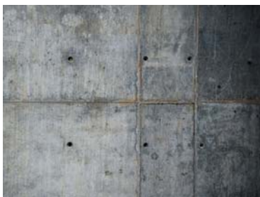
Beton (met anker-gaten en bekistingstextuur)
