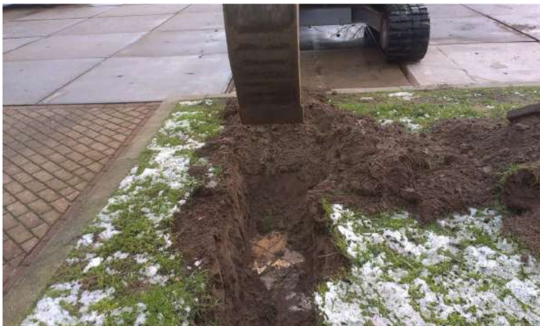
oude (betongelde) betonvloer bij sleuf S7
