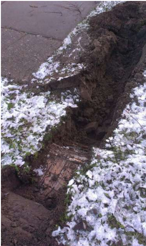
oude (betegelde) betonvloer bij sleuf S5
