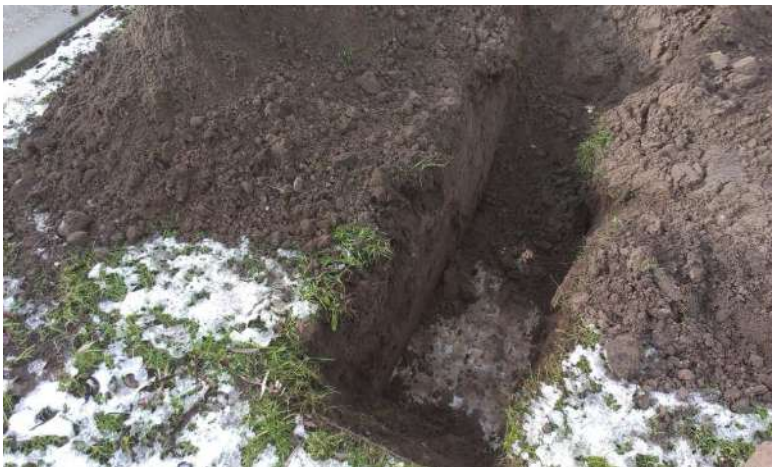
oude (betegelde) betonvloer bij sleuf S6
