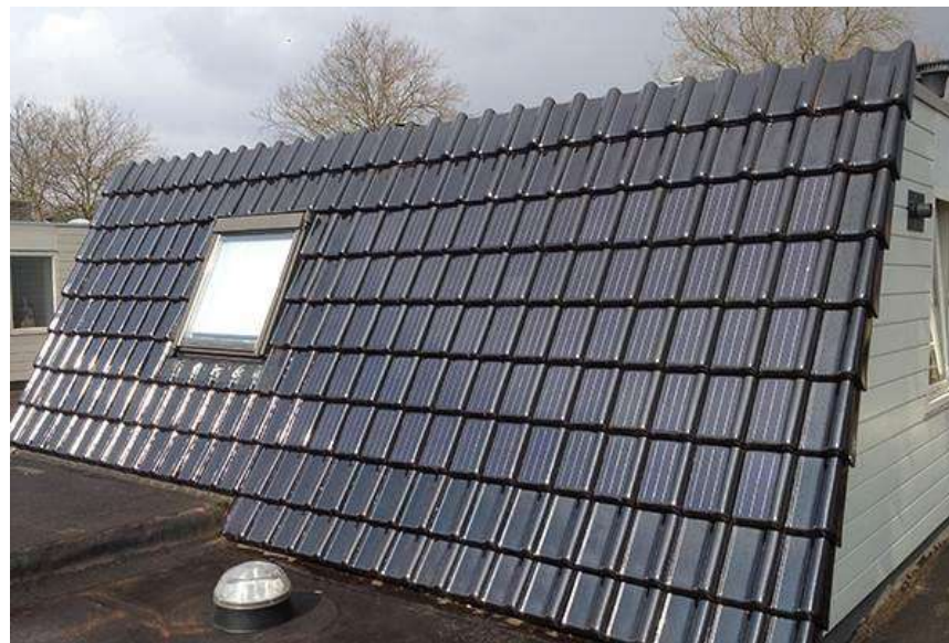
Afbeelding 42. Voorbeeld van antracietkleurige zonnepanelen op het dak.
