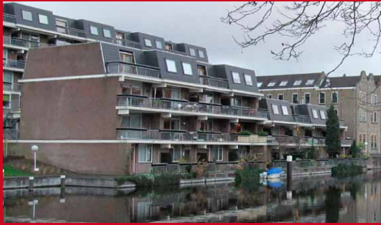
te sterke horizontale geleding, kappen passen niet in binnenstad
