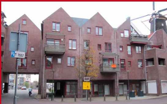
leegstaande plinten en te weinig detail in gevel
