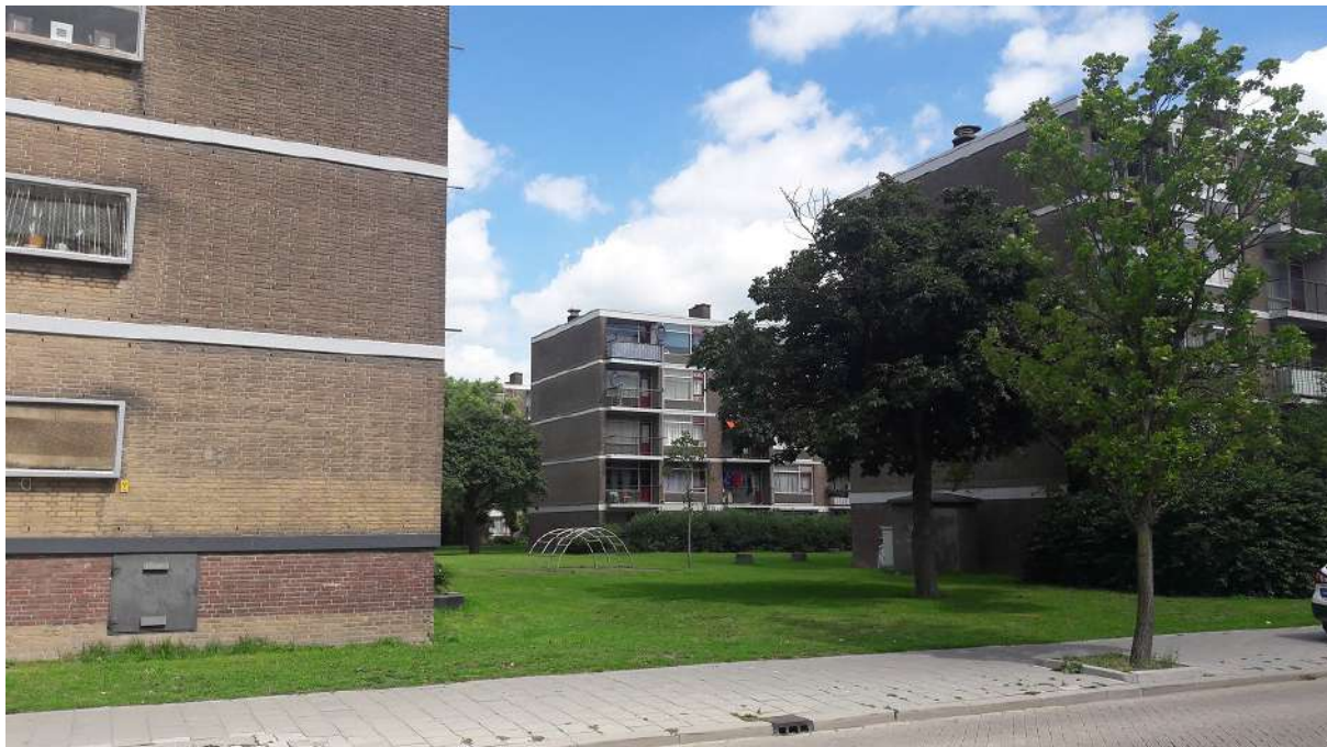
Flats aan westzijde van het plangebied met groen en open stootvoegen in de gevels.
