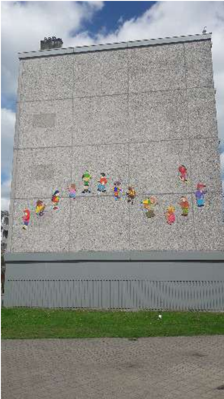
Gevel aan oostzijde van het plangebied.
