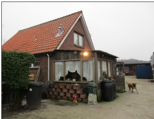
Foto 5: Te slopen woonhuis aan de Ockenburger Tientweg 24D
