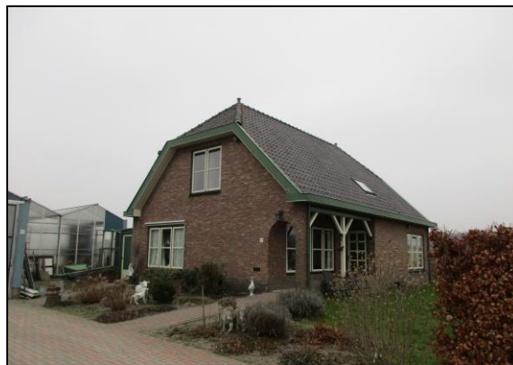
Foto 8: Te slopen woonhuis aan 't Haantje 19A
