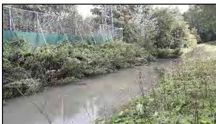
Figuur 18. Watergang langs noordwestzijde onderzoekslocatie, links het terrein van het partycentrum, kijkrichting noord.
