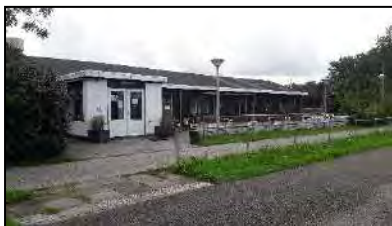
Figuur 12. Voorzijde clubgebouw 'De Spartaan'.
