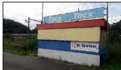
Figuur 16. Bijgebouw wielrenparcours zuidwestzijde onderzoekslocatie.
