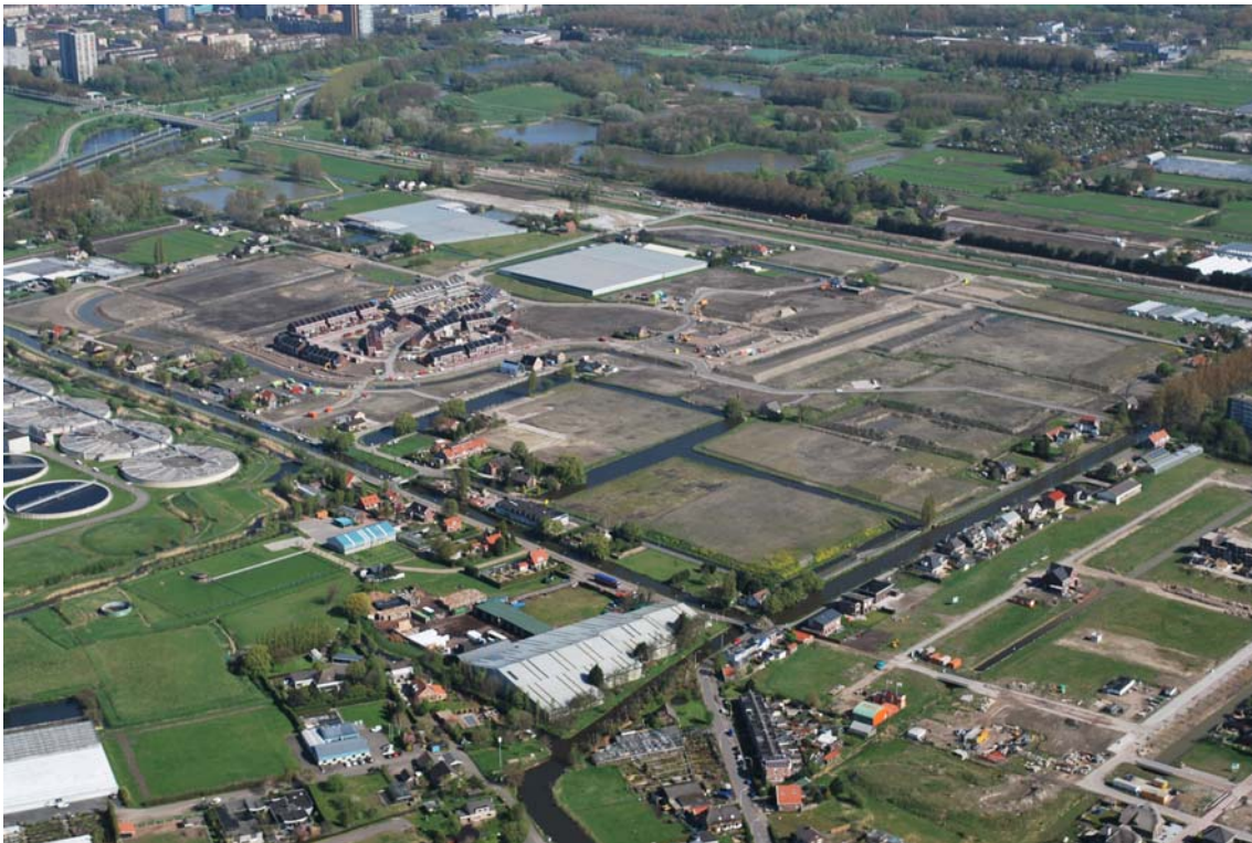
Afbeelding 2.2: luchtfoto RijswijkBuiten vanuit het zuidwesten (KuiperCompagnons, april 2014). Centraal in het plangebied zijn de reeds opgeleverde woningen in deelplan 1 (deelgebied Sion) zichtbaar.
