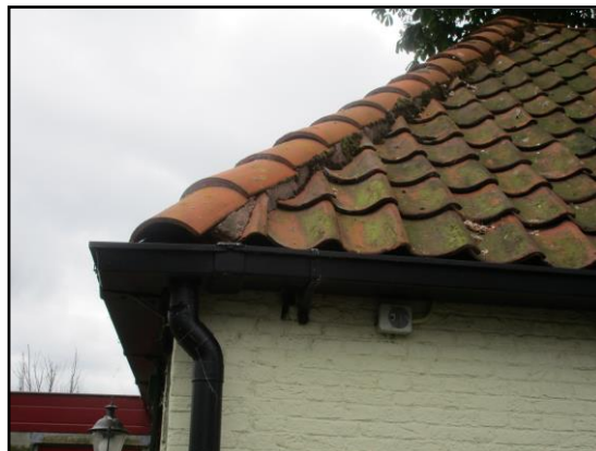
Foto 8: Geschikte ruimte onder dakpannen
