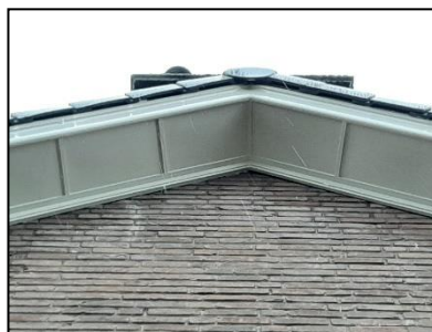
Figuur 16. Ruimtes onder de kant- en nokpannen bij kopgevel van de hoofdbebouwing op Van Vredenburgweg 95.
