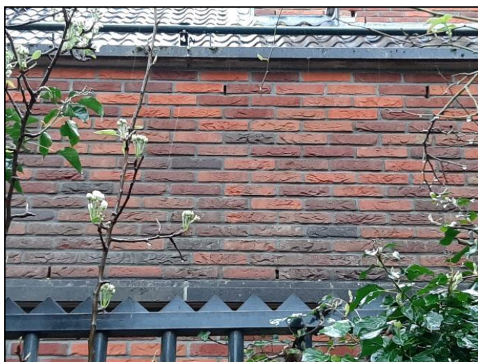
Figuur 19. Open stootvoegen in de noordelijke gevel van de bebouwing op de Park de Wervelaan 1.
