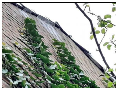
Figuur 14. Ruimtes onder de kant- en nokpannen bij kopgevel van de schuur van Van Vredenburgweg 97.
