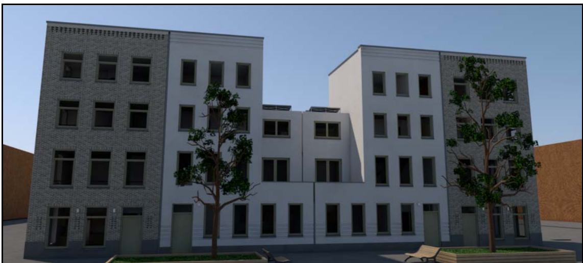
Afbeelding 6: Zicht op de noordgevel.
