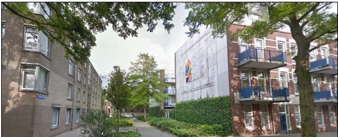
Afbeelding 4: Zicht op de projectlocatie met de blinde gevels gericht op het openbaar gebied.
