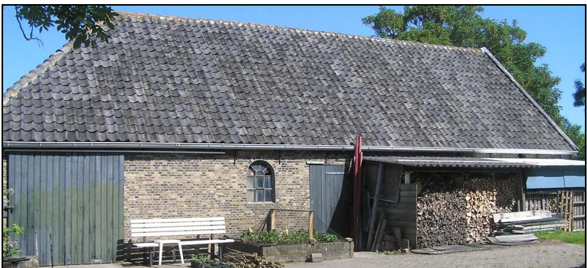
Afbeelding 5: De binnen het projectgebied aanwezige schuur.
