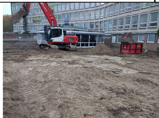
Foto 5: Spot II A overzicht sanering
