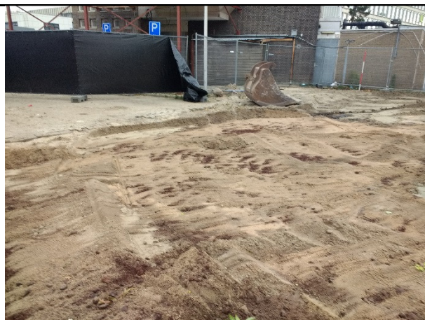
Foto 2: Spot I overzicht sanering
