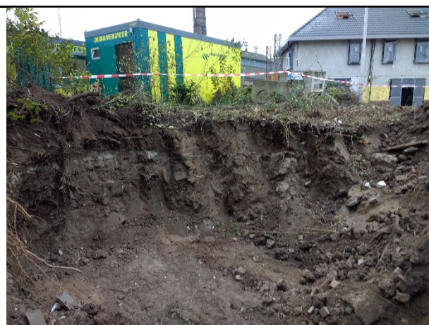
Foto 10: Spot II B overzicht sanering
