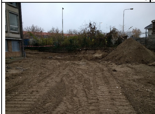
Foto 9: Spot II B overzicht sanering
