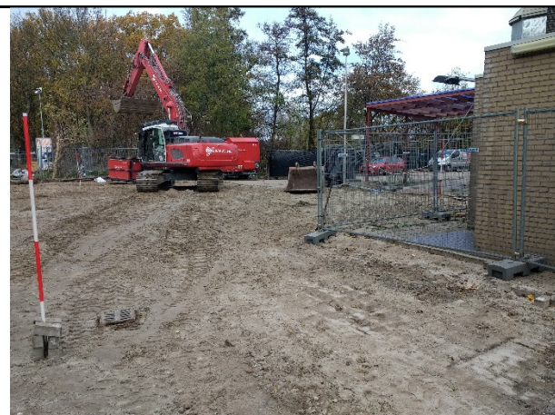
Foto 1: Spot I overzicht sanering
