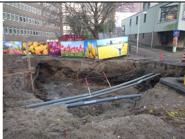
Foto 20: Spot IV overzicht sanering
