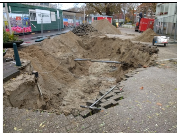
Foto 16: Spot III overzicht sanering
