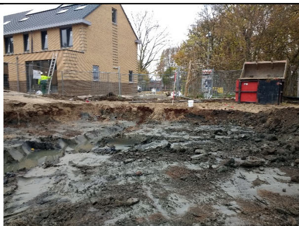
Foto 4: Spot I overzicht sanering
