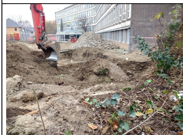
Foto 11: Spot II B overzicht sanering
