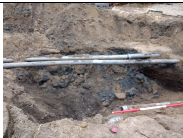
Foto 18: Spot IV overzicht sanering
