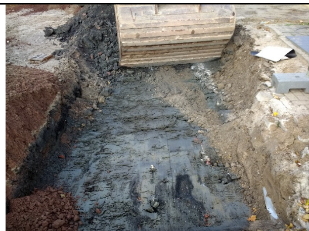
Foto 3: Spot I overzicht sanering
