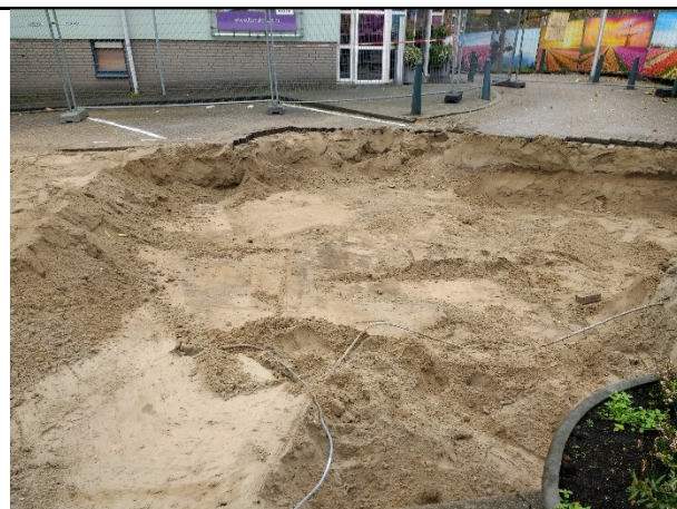
Foto 14: Spot III overzicht sanering
