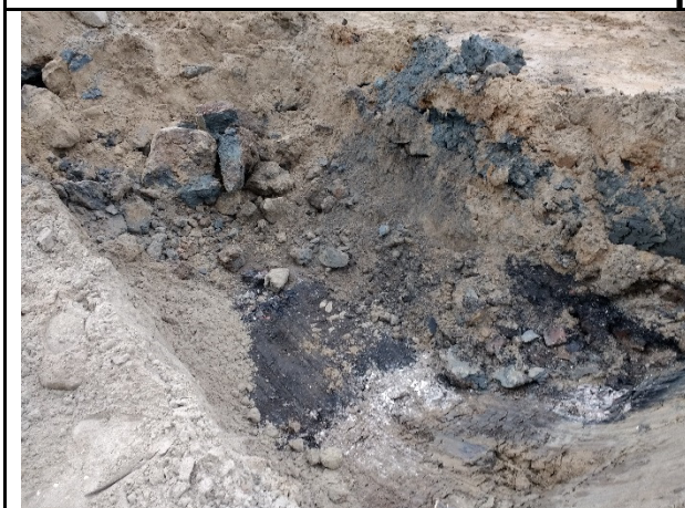
Foto 17: Spot IV overzicht sanering
