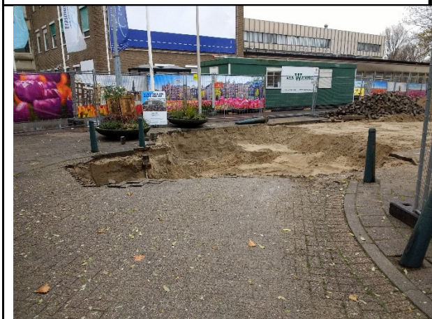
Foto 13: Spot III overzicht sanering
