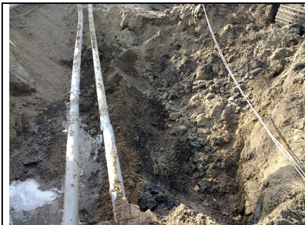
Foto 19: Spot IV overzicht sanering
