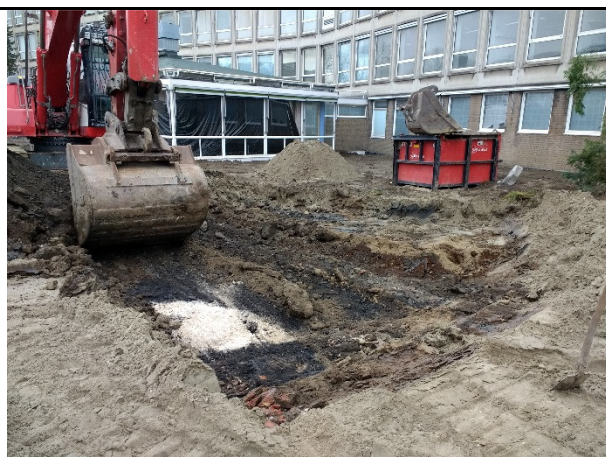
Foto 6: Spot II A overzicht sanering
