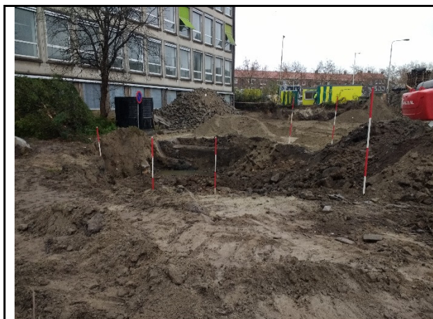
Foto 7: Spot II A overzicht sanering
