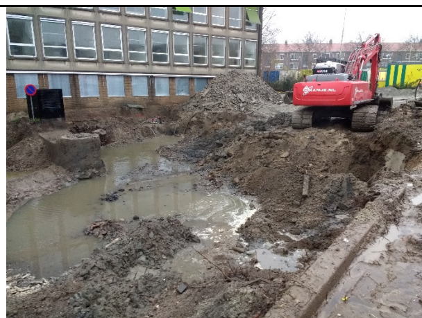
Foto 8: Spot II A overzicht sanering
