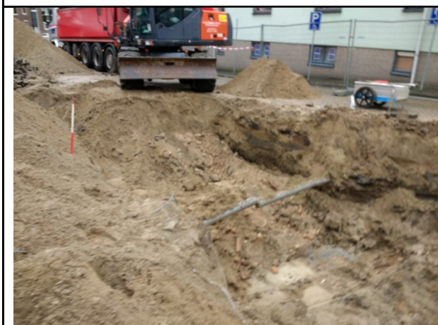
Foto 15: Spot III overzicht sanering
