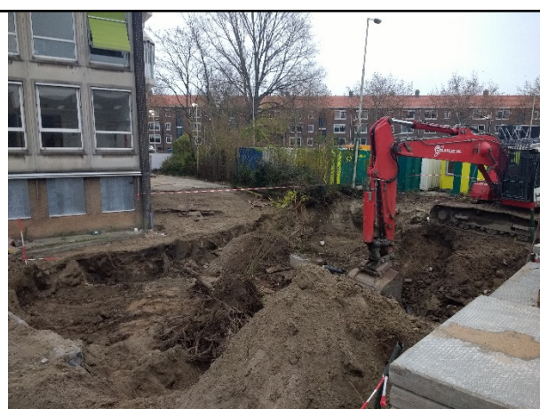
Foto 12: Spot II B overzicht sanering
