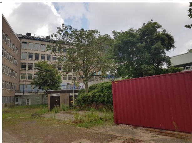
10. Aanzicht brug naar hoofdingang
