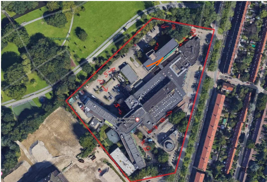
Fig 2.1: Ligging planlocatie: aangeduid met een rode contourlijn. Ten Noorden van het ziekenhuis ziet een publiek park liggen, de Valkeniersweide. Ten Westen van de planlocatie zijn er reeds nieuwe woningen gebouwd. Deze locatie is op foto nog als bouwterrein te herkennen.
