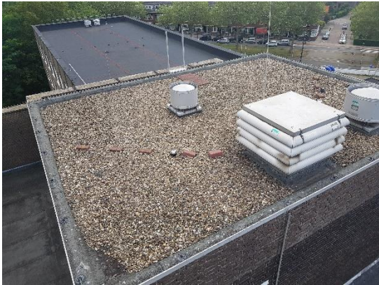
Fig 2.4: dakbedekking met grind
