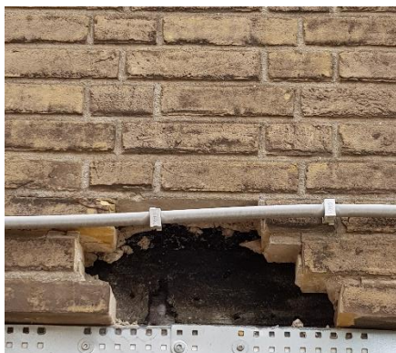
Fig 2.3: gat gemaakt tijdens asbestonderzoek
