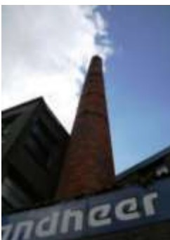
Figuur 2.4b gierzwaluw in woningen aan de in de fabriekspijp aan de Kerkhofstraat buiten het plangebied
