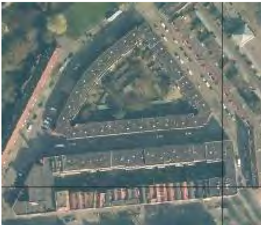
Luchtfoto onderzoekslocatie Paradijshof
