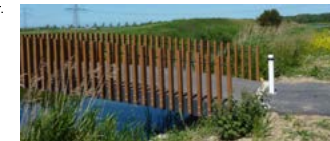
foto hoofdstructuurbrug in Oranjebuitenpolder
