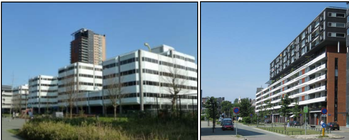
Afbeelding 4: Links het te slopen kantoorgebouw, rechts het woongebouw 'Gedempte Zalmhaven'.
