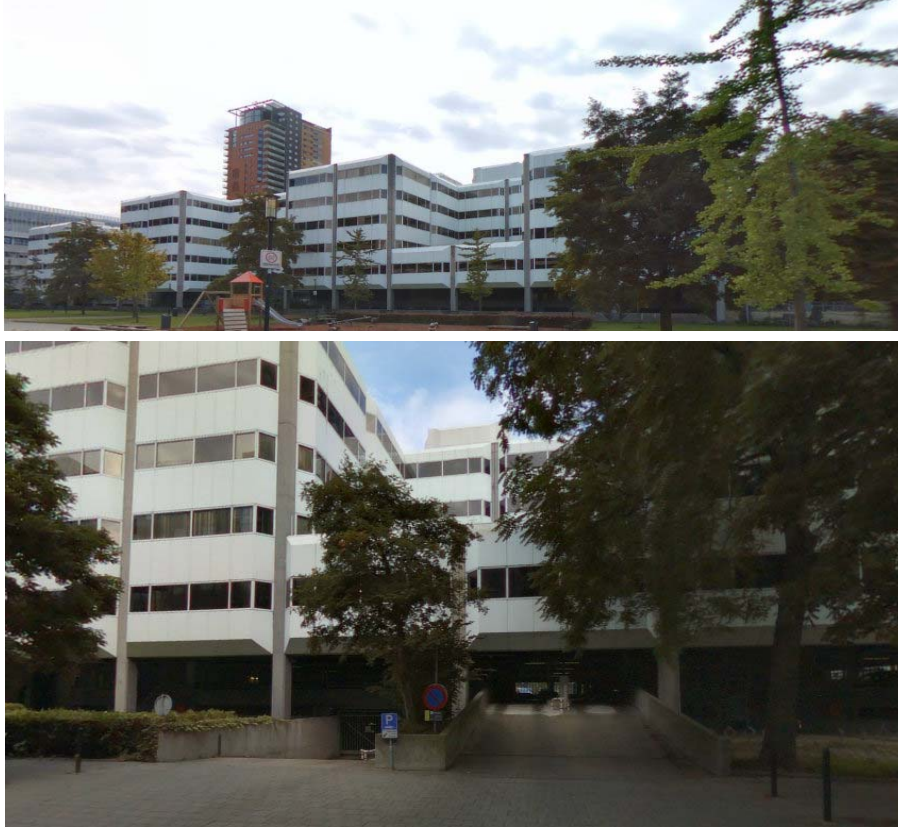
Figuur 2.1: Het huidige gebouw vanaf de Gedempte Zalmhaven (boven) en de Houtlaan (onder)
