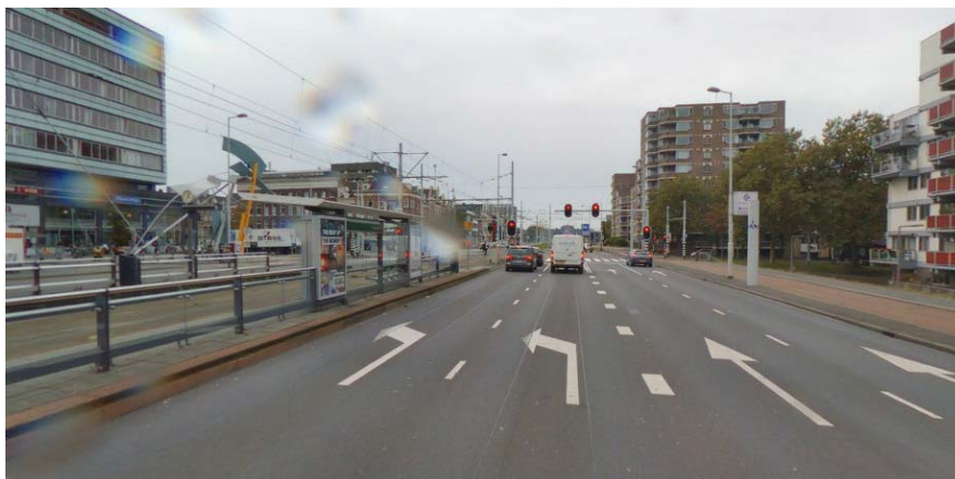
Figuur 5.2: Kruispunt Vasteland - Scheepstimmermanslaan met twee opstelstroken voor linksaf op het Vasteland
