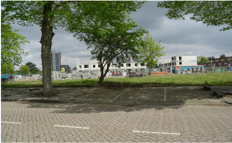
ZW1 gezien vanuit het westen is reeds in aanbouw. Foto: K.J. van Veen | Ecoresult B.V.
