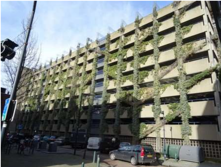
Gevelgroen op de parkeergarage aan de Hartmansstraat. K. van Veen | Ecoresult B.V.
