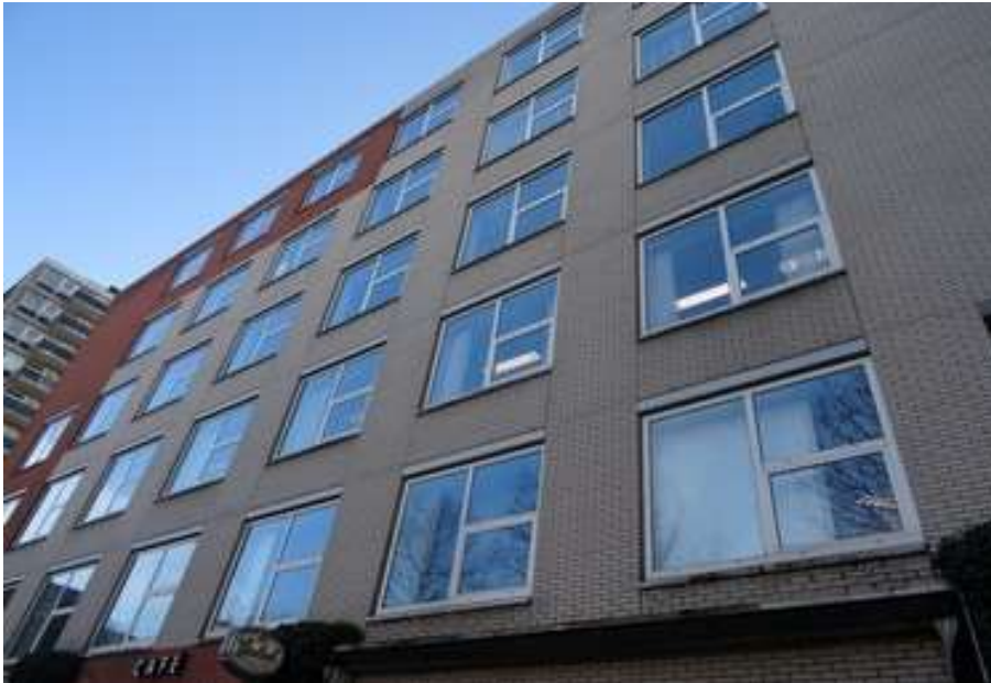
Bebouwing met open stootvoegen bieden voor vleermuizen toegang tot de luchtpouw. K. van Veen | Ecoresult B.V.
