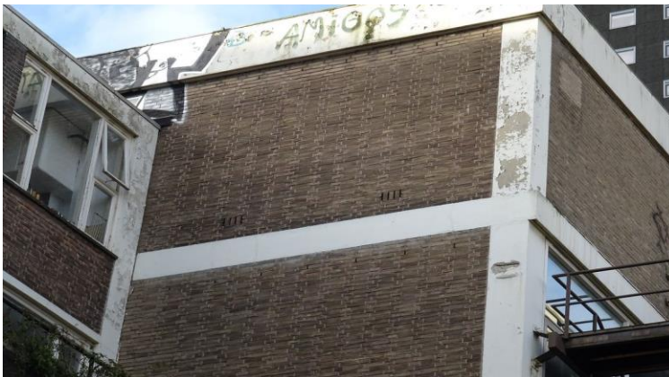
Gevel met open stootvoegen en ventilatieroosters. Foto: K.J. van Veen | Ecoresult B.V.
