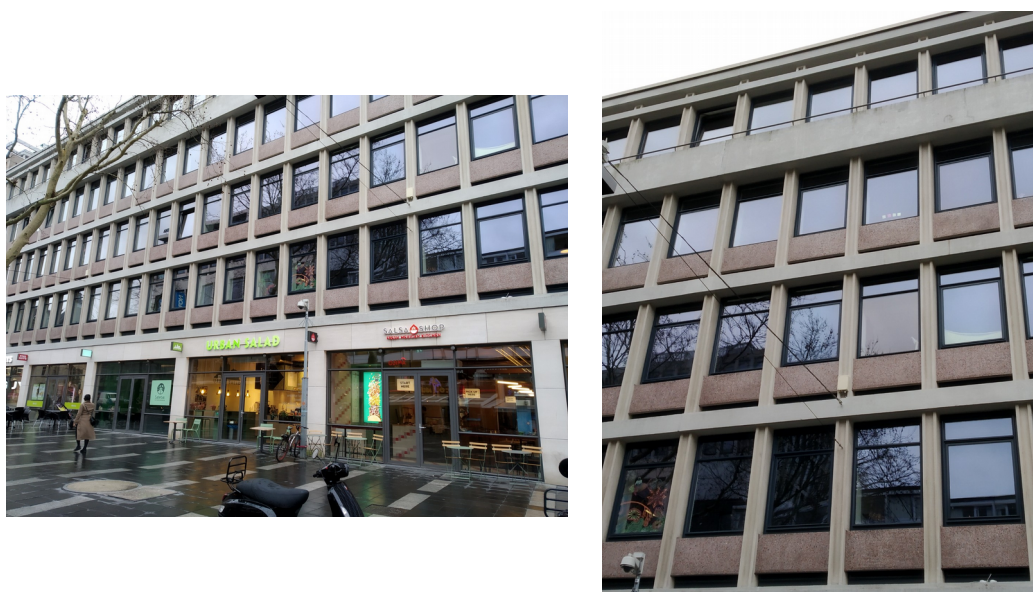
f6.1 Gevel van de studentenwoningen
