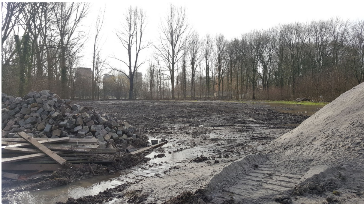
Oostelijke bouwkaavel gezien vanaf de noordzijde. Foto: B. Verhoeven | Ecoresult B.V.
