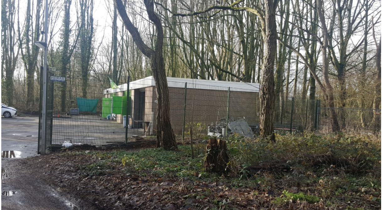
Bebouwing op de westelijke bouwkevel. Foto: B. Verhoeven | Ecoresult B.V.
