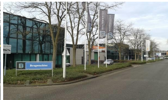
Locatie voormalig barakkencomplex
