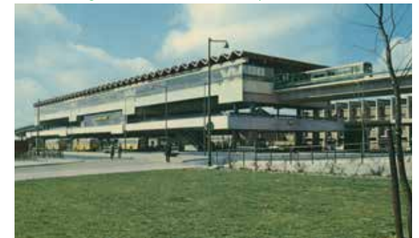
Afbeelding 2.3 Metrostation Zuidplein vlak na bouw
