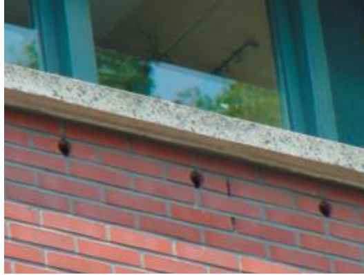
Foto 4.5: ingemetselde vleermuis en/of vogelkasten
