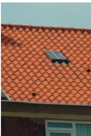
Foto 4.2: gierzwaluwdakpannen op dak
