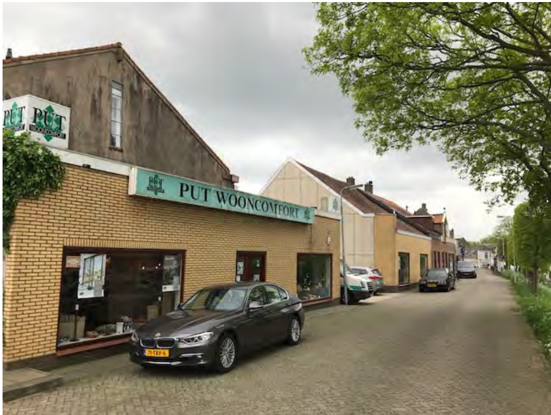
Figuur 3.2 Bestaande situatie
