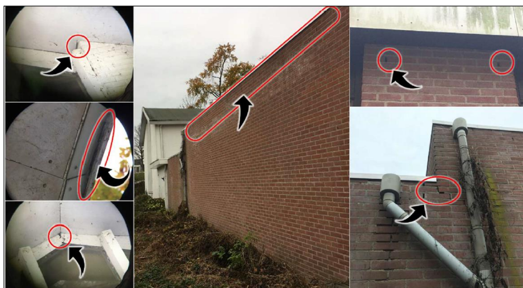
Figuur 1.3 Middels open stootvoegen, kierende daklijsten en andere openingen kunnen vleermuizen toegang krijgen tot potentiële verblijfplaatsen in de bebouwing op de planlocatie.
