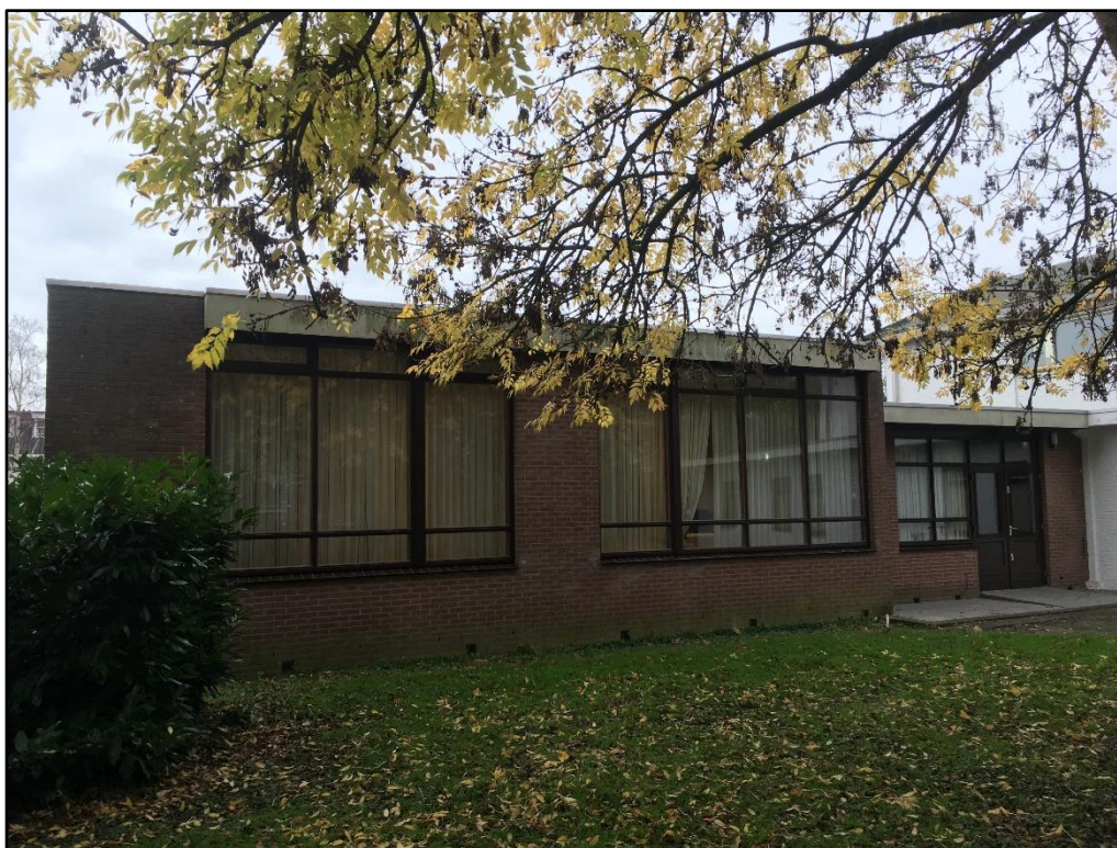
Figuur 2 Het oudere deel van de kerk is opgetrokken uit gemetselde muren en draagt een bitumen dak zadeldak. De entree van de kerk draagt een plat dak.
