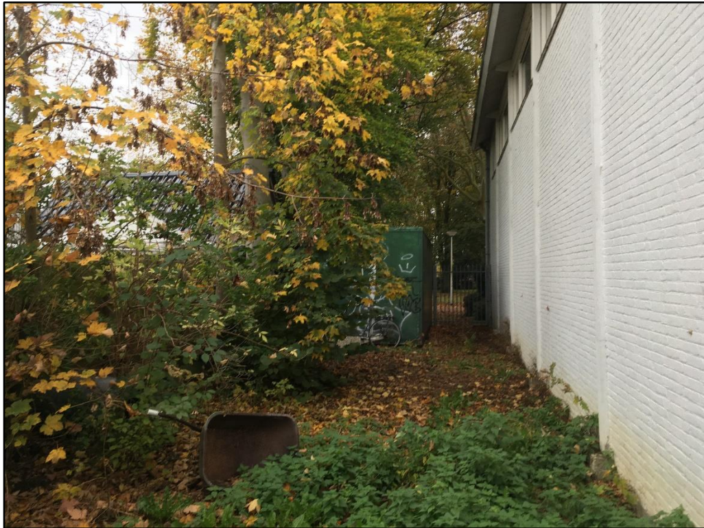
Figuur 3 De jongere aanbouw is opgetrokken uit gemetselde muren met spouw en draagt een plat dak. Aan de zuidzijde van de kerk is tevens een zeecontainer gesitueerd welke dienst doet als tuinhuis.
