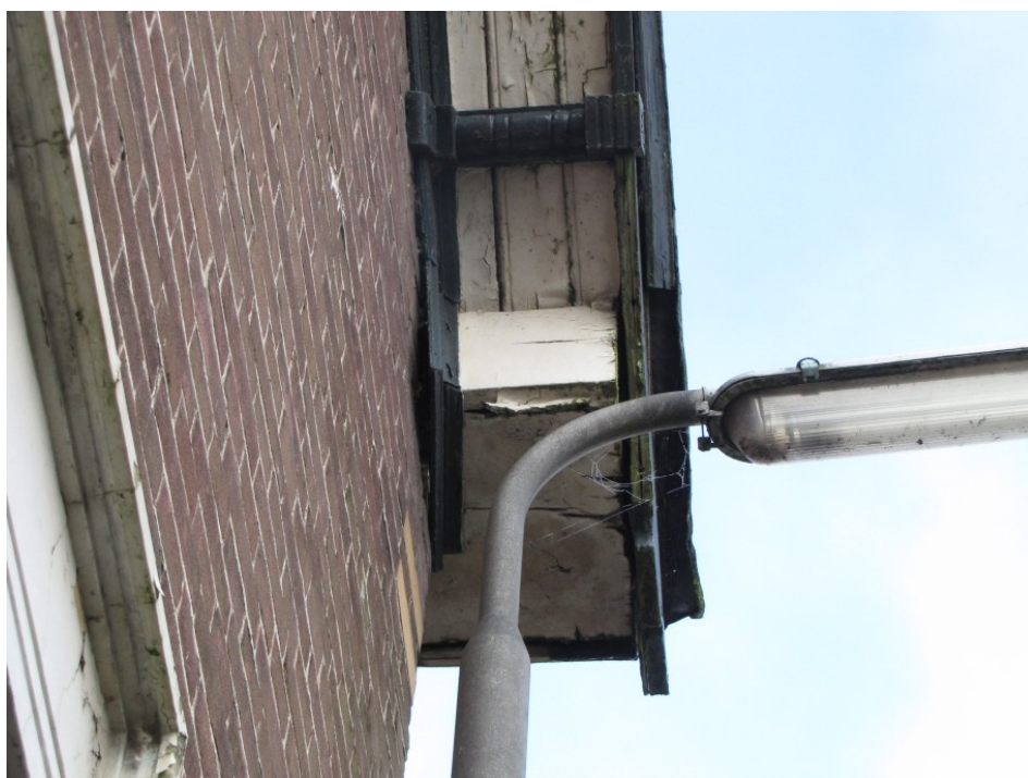
Figuur 4. Voor vleermuizen toegankelijke ruimte achter betimmering.
