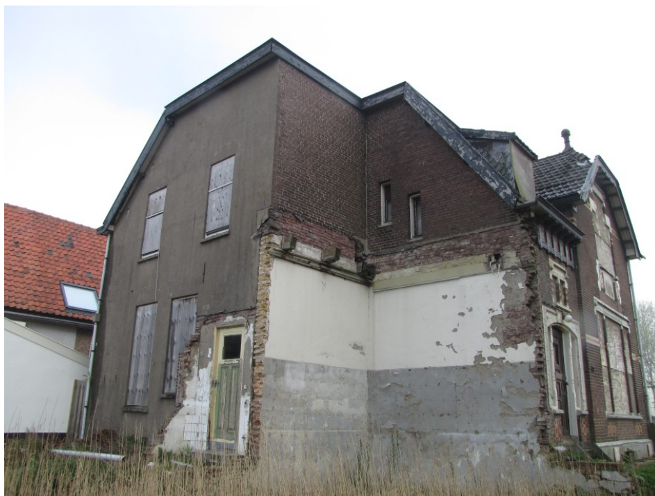
Figuur 2. Te slopen schoolmeesterswoning.
