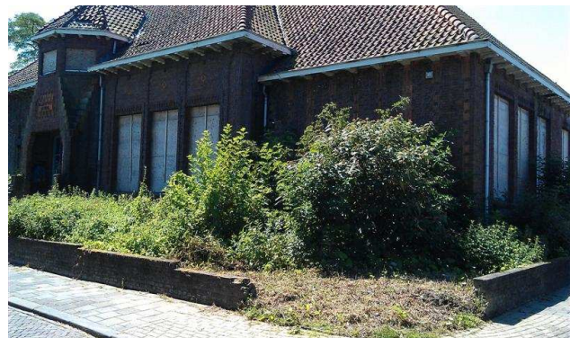
foto 8: locatie HBO-tank op hoek Dr. Kuiperstraat - Klaas Katerstraat
