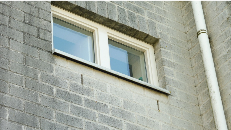
Detail bedrijfspand: open stootvoegen geschikt voor vleermuizen
