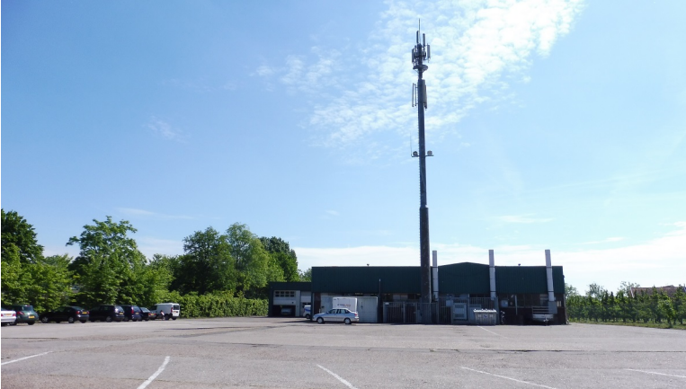
Afbeelding 2: De loods met de zendmast
