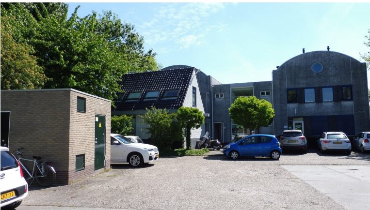
Afbeelding 3: Het bedrijfspand op de achtergrond, met links het woonhuis en het transformatorhuisje
