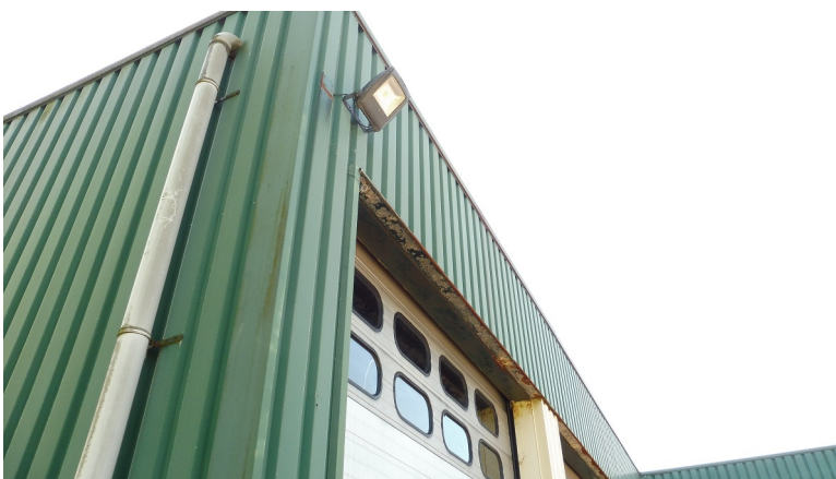
Detail van loods: ongeschikt voor vogels of vleermuizen
